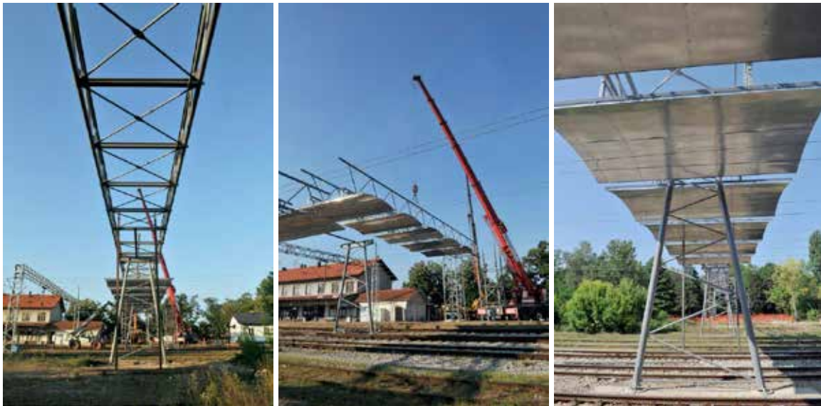
Slika 8: Gradnja pasarele na željezničkom kolodvoru Caprag u Sisku
