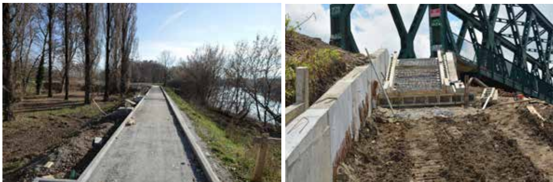
Slika 20: Izgradnja šetnice od Mihanovićeve obale do Starog grada
