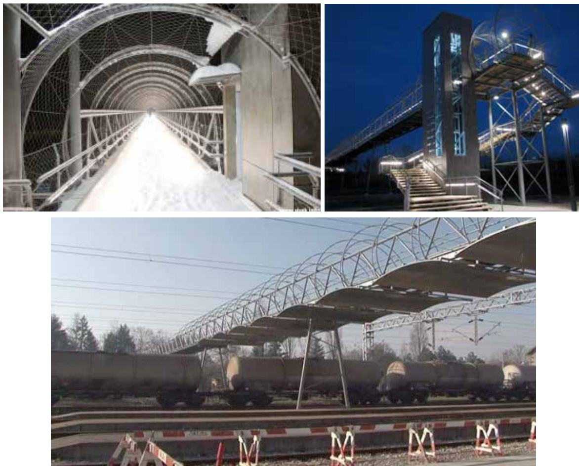
Slika 9: Pasarela na željezničkom kolodvoru Caprag u Sisku
