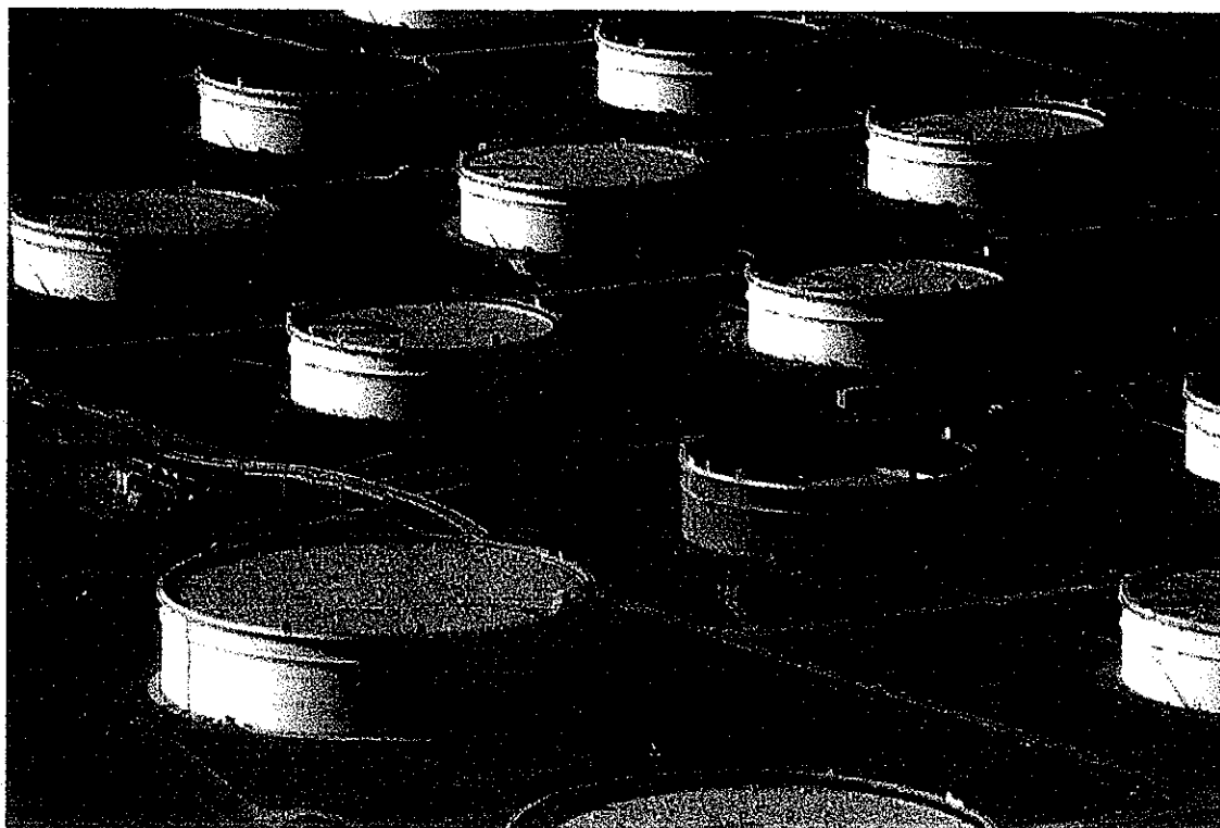
Slika 5 Izgradnja novog rezervoarskog prostora JANAF d.o.o.
