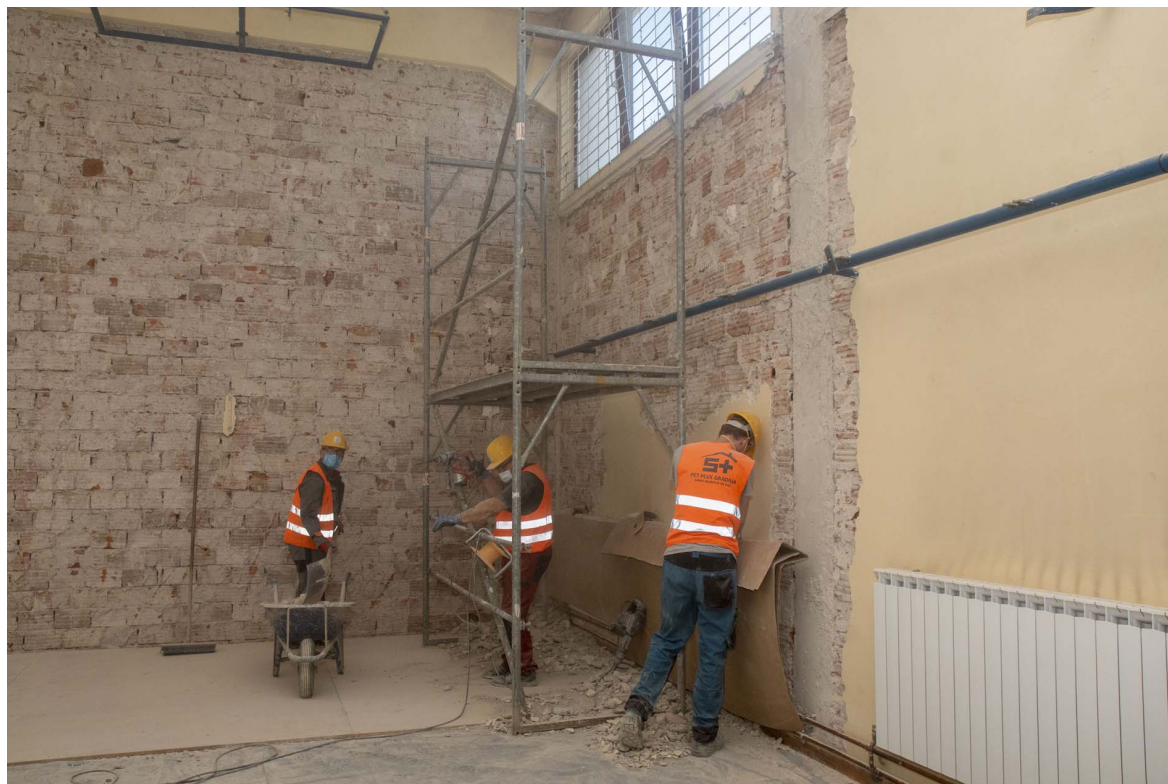
Slika 46. Radovi na obnovi OŠ Viktorovac
