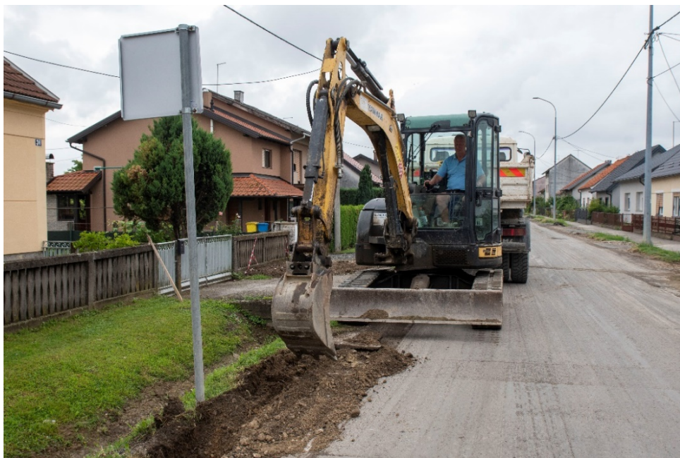
Slika 61. Radovi na rekonstrukciji Ulice Brezovičkog odreda
