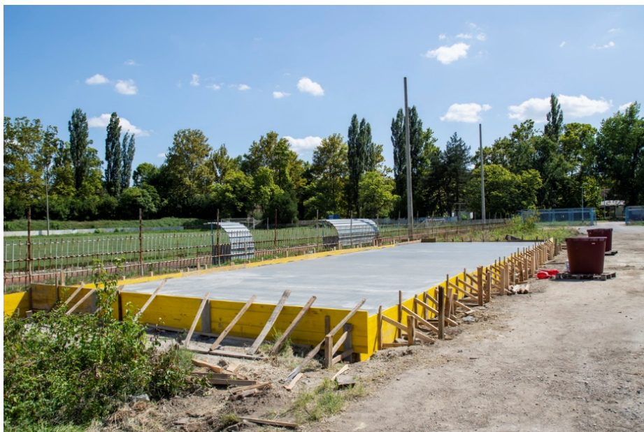
Slika 31. Radovi na izgradnji tribina na stadionu Metalca
