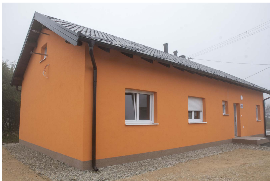
Slika 55. Izgrađena prva zamjenska kuća u Galdovu
