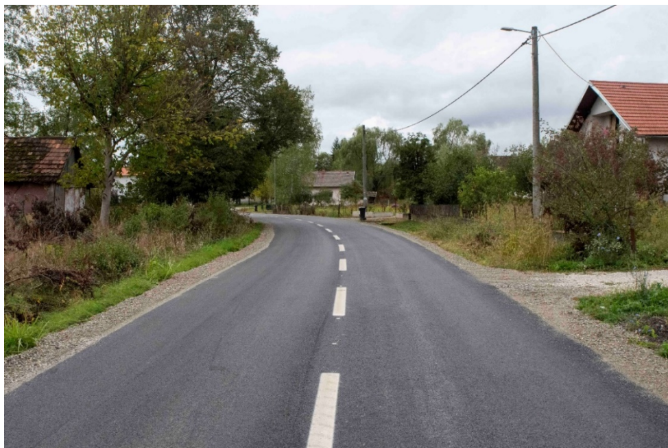
Slika 36. Novi asfalt na prometnici Madžari-Letovanci
