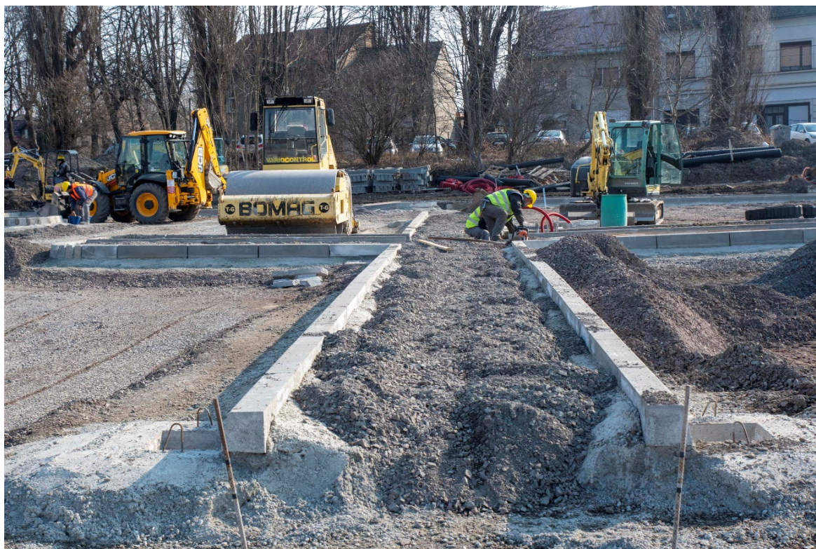
Slika 41. Radovi na PARK&RIDE parkiralištu
