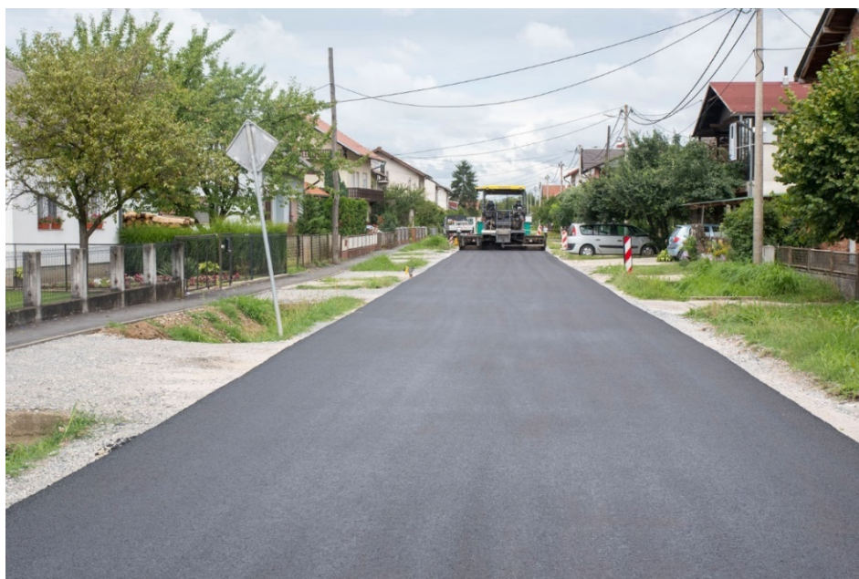
Slika 62. Asfaltiranje Poljske ulice
