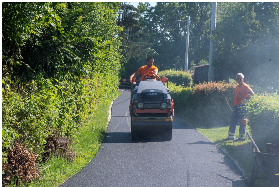
Slika 48. Novi asfalt na području sela Jazvenik
