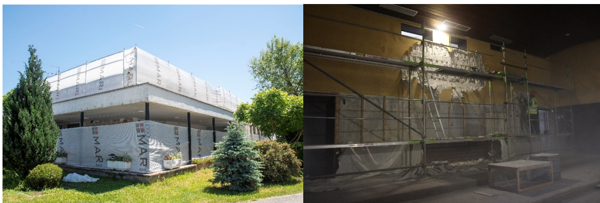
Slika 47. Radovi na Kazalištu-21
