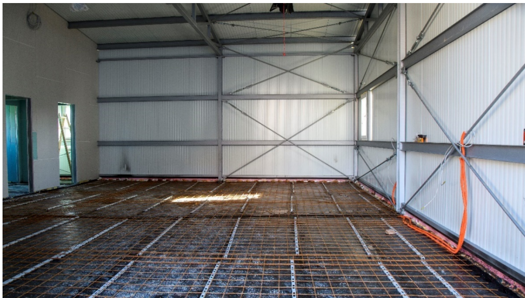
Slika 66. Izgradnja skladišta DVD-Topolovac
