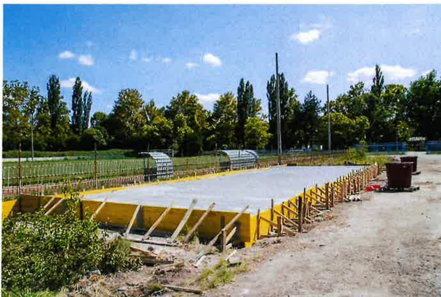
Slika 31. Radovi na izgradnji tribina na stadionu Matalca
