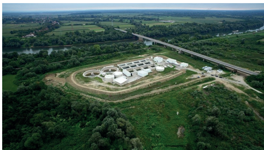
Sl. 3.2-1: Uređaj za pročišćavanje otpadnih voda (Izvor: Sisački vodovod)
