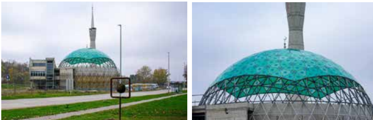
Slika 49 Gradnja islamskog centra u Sisku
