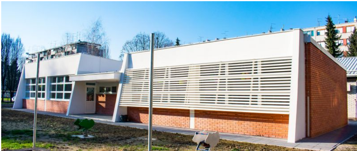
Slika 37 Dogradnja vrtića Bubamara u Sisku
