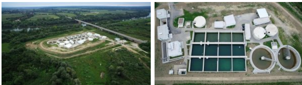
Slika 70 Uređaj za pročišćavanje otpadnih voda u Sisku
