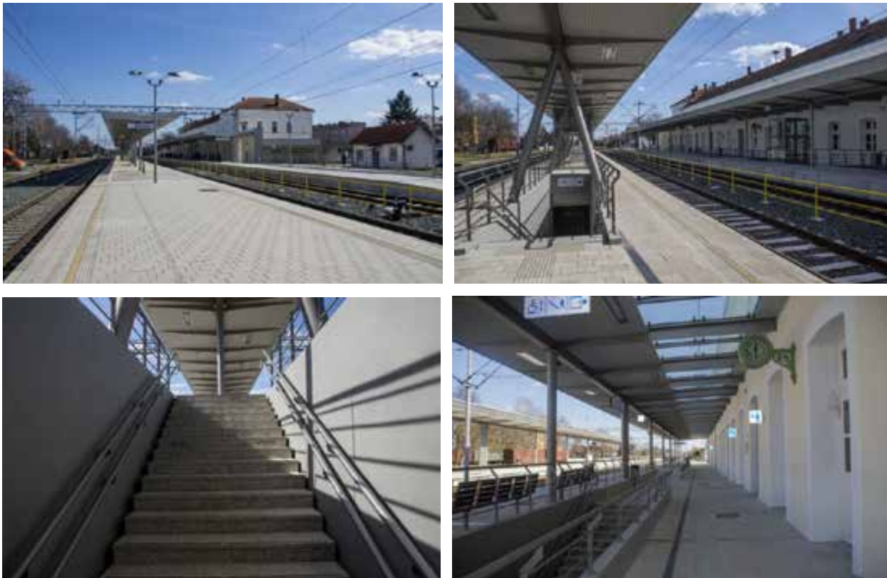
Slika 4 Rekonstrukcija putničkog kolodvora u Sisku
