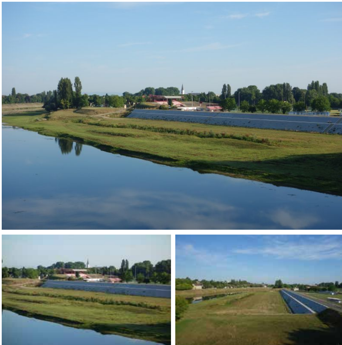
Slika 6 Dovršeni dio prve etape izgradnje komunalnog pristaništa na rijeci Kupi u Sisku
