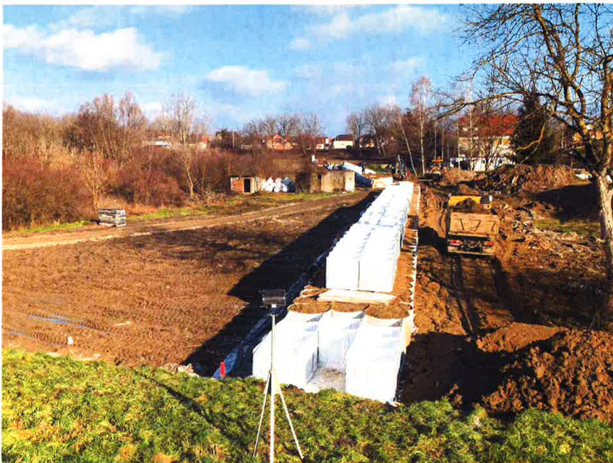
Slika 10 Postavljanje druge linije obrane od box barijera punjenih zemljanim materijalom, na lijevom savskom nasipu u Sisku (područje Galdovo) odmah nakon razornog potresa
