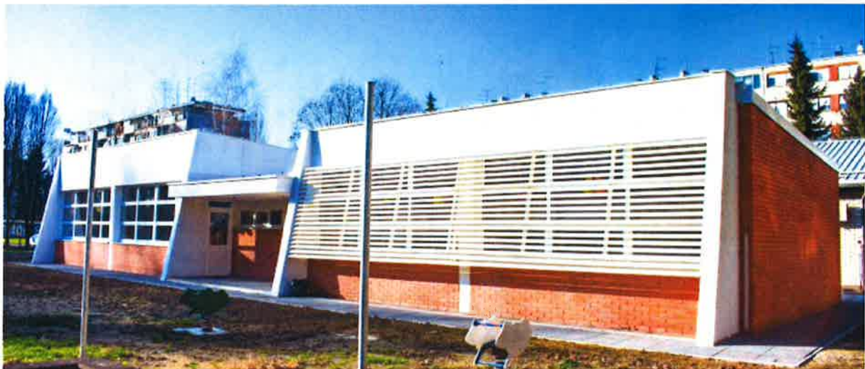
Slika 37 Dogradnja vrtića Bubamara u Sisku
