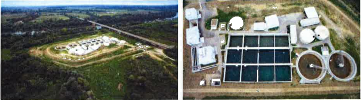
Slika 70 Uređaj za pročišćavanje otpadnih voda u Sisku
