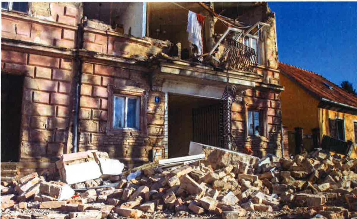
Slika 53 Sisak poslije potresa / Mihanovićeveva obala
