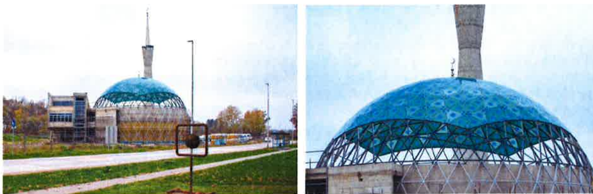
Slika 49 Gradnja islamskog centra u Sisku
