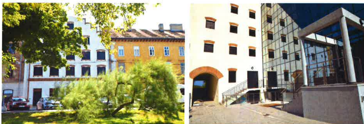
Slika 35 Pročelje i dvorišna fasada „Holandske kuće“ u Sisku
