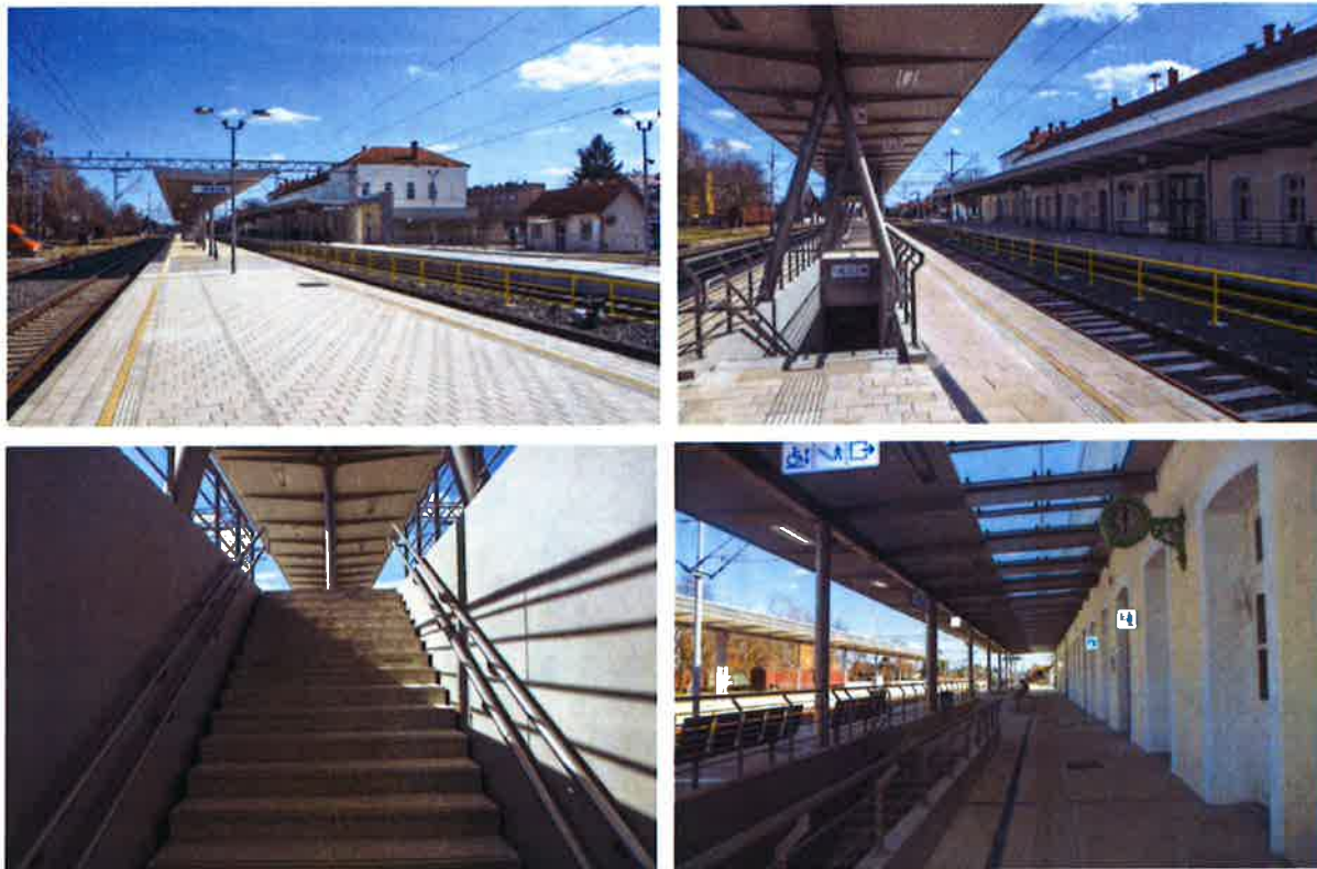
Slika 4 Rekonstrukcija putničkog kolodvora u Sisku
