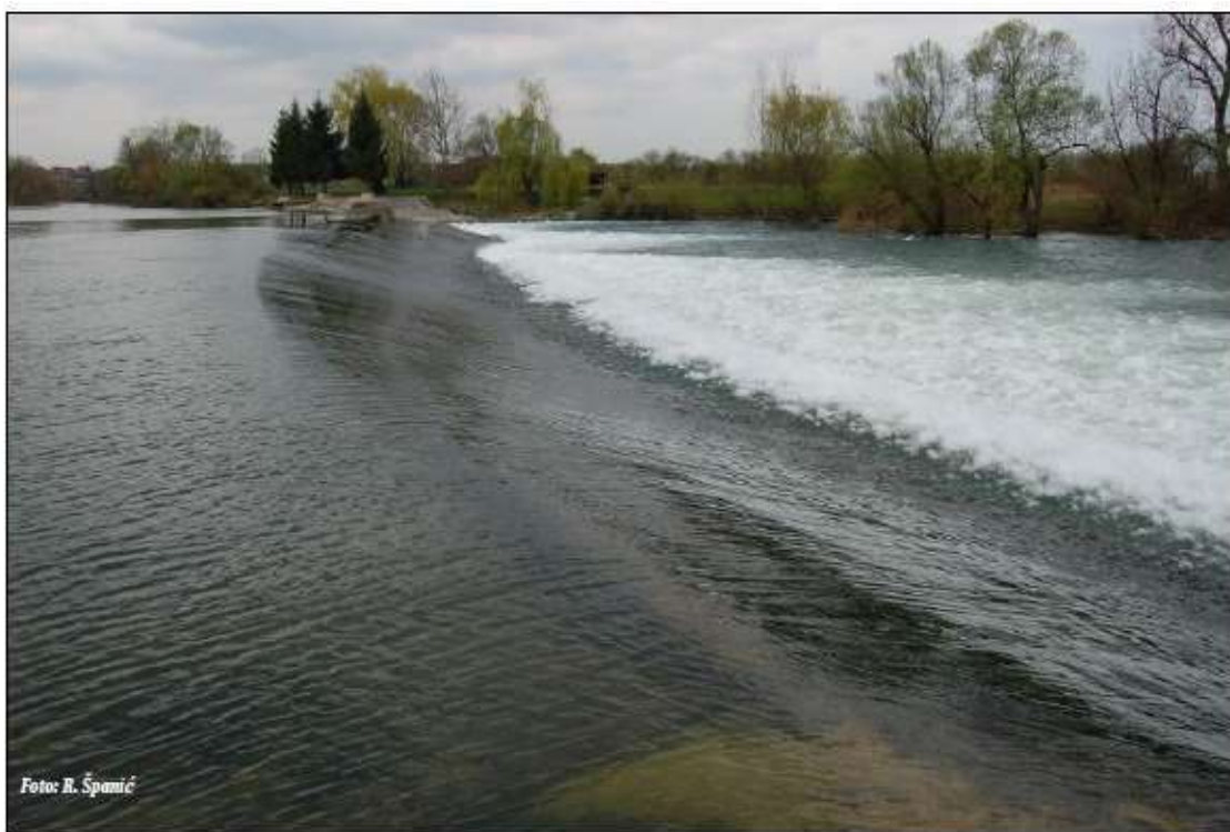
Slika 4-56 Postojeća brana na lokaciji zahvata MHE Odeta 1
