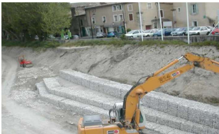
Slika 5-2 Prikaz gradnje sa gabionskim elementima
