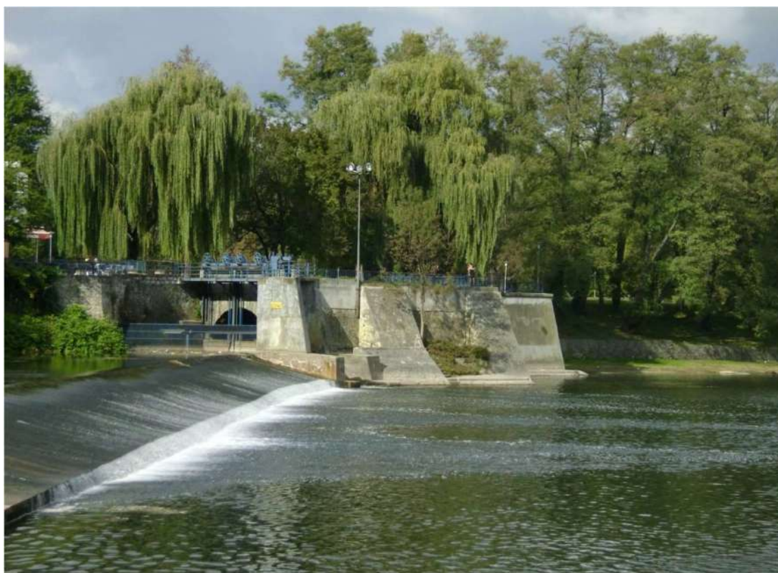
Slika 4-62 Postojeća brana na lokaciji zahvata MHE Korana 1
