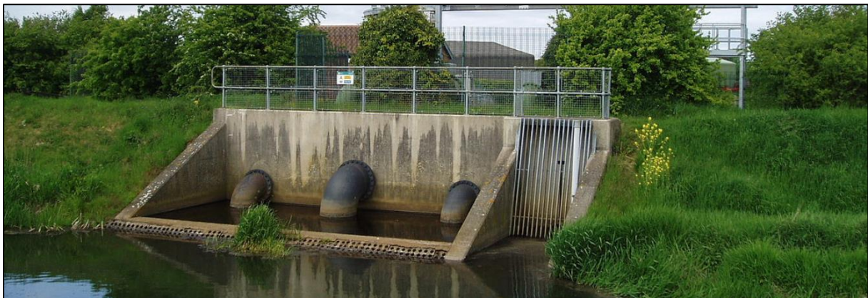
Slika 14. Primjer crpne stanice
