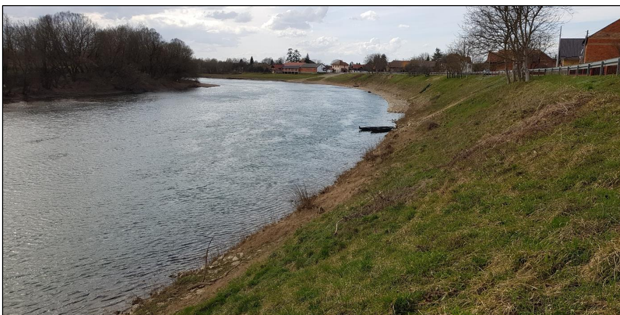
Slika 61. Lokacija postojeće obaloutvrde – pogled uzvodno
