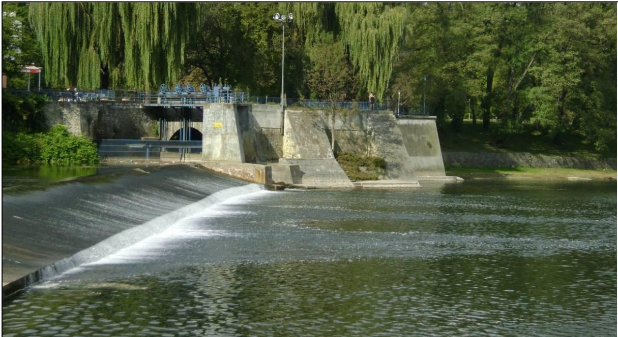
Slika 138. Postojeća brana na lokaciji zahvata MHE Korana 1
