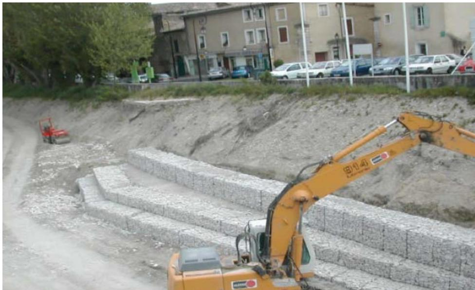
Slika 5.2 Prikaz gradnje sa gabionskim elementima
