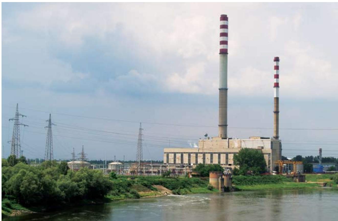
▲ Pogled na termoelekttranu u Sisku
