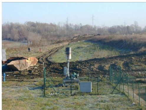
Slika 6.2. Baklja za sagorijevanje odlagališnih plinova
