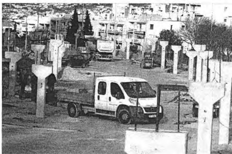
Na Visokoj, Sućidru i Mertojaku već se grade garaže
