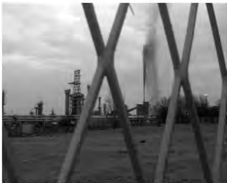
Slika 7.1.1 Propuštanje sigurnosnog ventila na postrojenju kokinga
