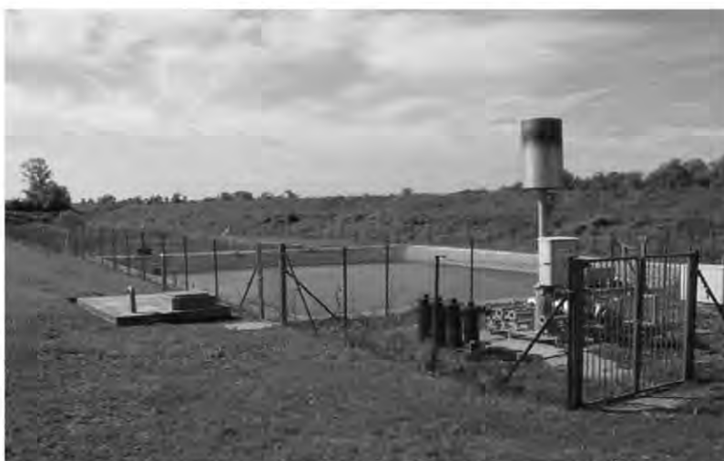
Slika 6.3.2. Biljno-biološki uređaj i baklja za spaljivanje odlagališnog plina
